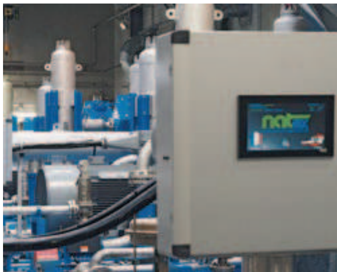
Neben verteilten Überwachungsfunktionen bieten die B&R-Bedienterminals dem Anlagenbetreiber eine Reihe wichtiger Aufgaben - vom Öffnen und Schließen der Hochdruckschnellverschlüsse bis zum Starten des Subsystems das jeden Extraktor mit Kork füllt oder leert. (Quelle: Diam Bouchage)
